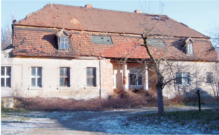
Herrenhaus Brahmov, Straßenansicht, Zustand Januar 2004
