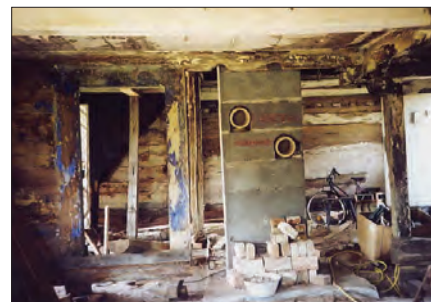
Die Spreewaldstube vor der Sanierung 1997
