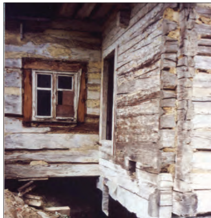
darunter: Ein Blick auf die Wandkonstruktion und die Fundamente, die ebenfalls in traditioneller Bauweise erneuert wurden.
